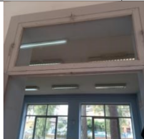
protezione dei vetri sulle porte con pellicola trasparente.
