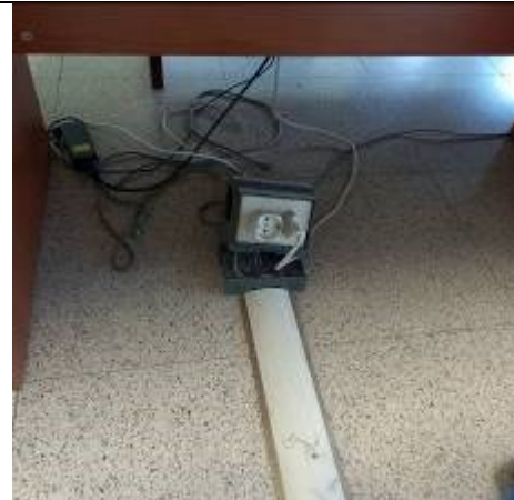
Sollevare i cavi che passano sul pavimento
