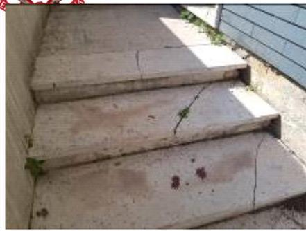
Provvedere a segnalare con nastro gommato e cartelli il pericolo d'inciampo per gradini rotti
