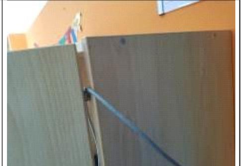
Cavo di corrente volante per funzionamento stampante. Provvedere alla risoluzione della criticità
