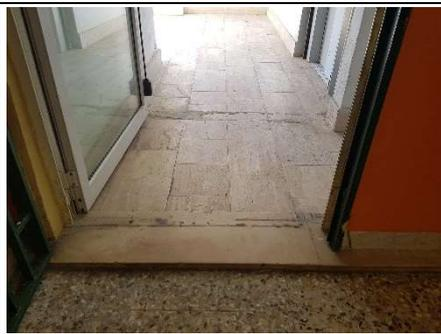
Provvedere a segnalare con nastro gommato e cartelli il pericolo d'inciampo più evidente
