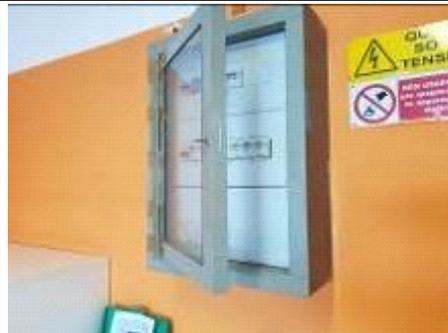
I quadri elettrici devono essere sempre tenuti chiusi a chiave e segnalato il rischio con cartelli di pericolo. Per quelli privi di sportello provvedere a proteggere con elementi provvisori. Provvedere a segnalare il pericolo con cartelli di attenzione
